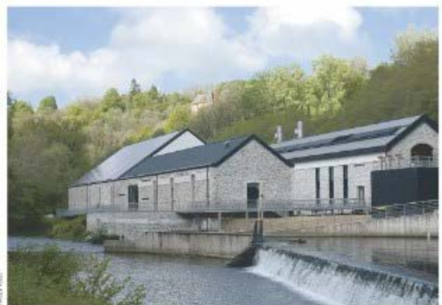
Ingépôle a pris part à la transformation en auditorium de cette ancienne papeterie, située à Uzerche (Corrèze).
